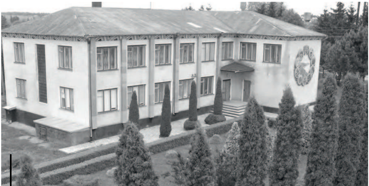
Адмінбудинок Новоушицького лісгоспу
