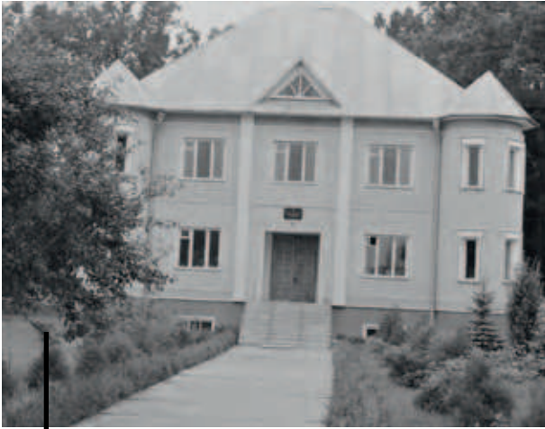
Адмінбудинок Плужнянського лісництва
