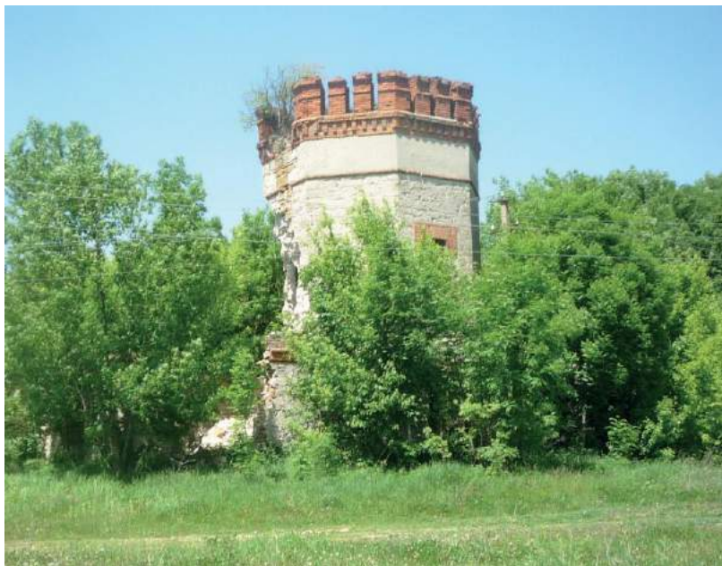
Водонапірна башта (зруйнована), с. Глібів.
