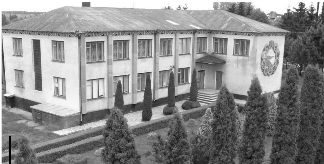
Адмінбудинок Новоушицького лісгоспу
