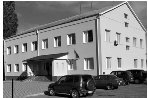
Адмінбудинок Хмельницького лісництва
