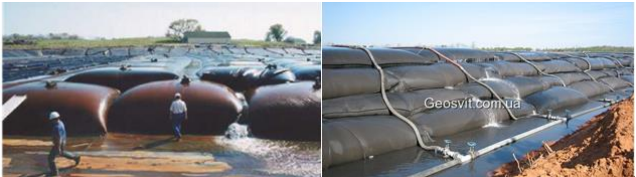
Рис. 2. Ілюстрація технології геотекстильних контейнерів Geotube
